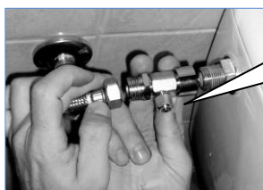
A. Zainstaluj trójnik na przewodzie doprowadzającym wodę
